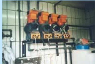
Quattro pompe dosano Anolyte nelle stazioni di rifornimento
