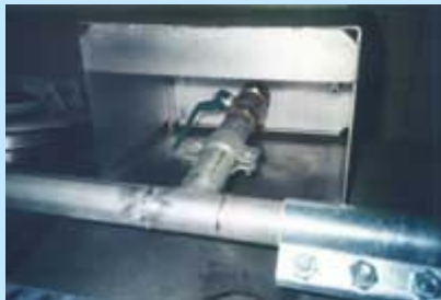
Punto di dosaggio per Anolyte
