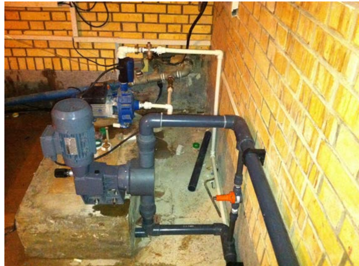
Pompa per l'iniezione di Anolyte
