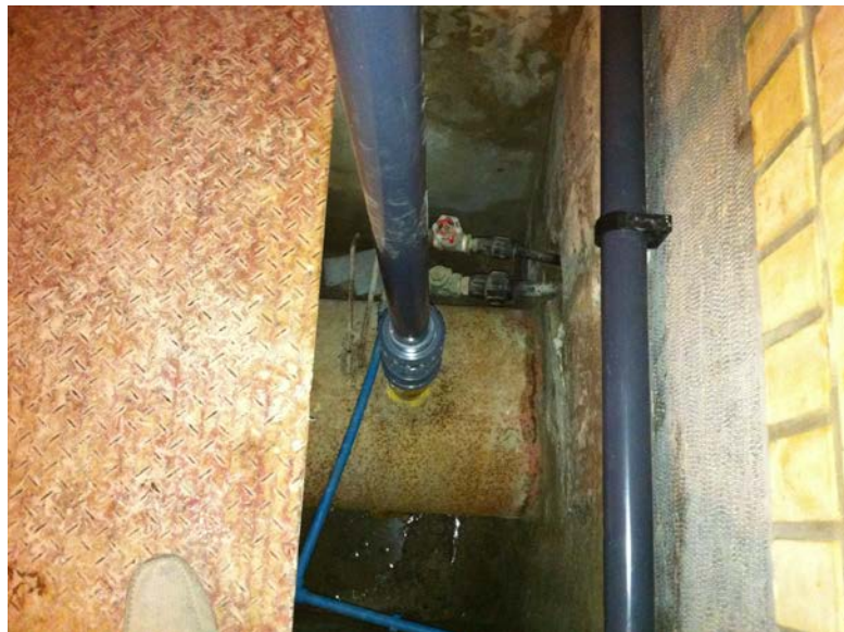
Punto di iniezione dell'Anolyte
